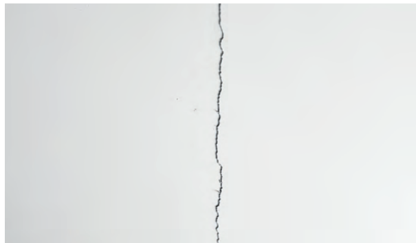
Vue d'une fissure « vivante »
