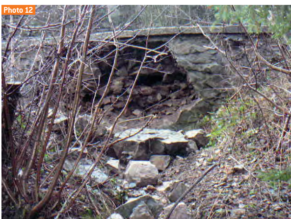
Exemples de lacunes en blocs (départ de la maçonnerie de parement) ou formation de cavité dans la maçonnerie.
