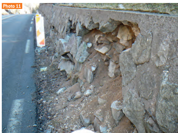
Exemples de lacunes en blocs (départ de la maçonnerie de parement) ou formation de cavité dans la maçonnerie.
