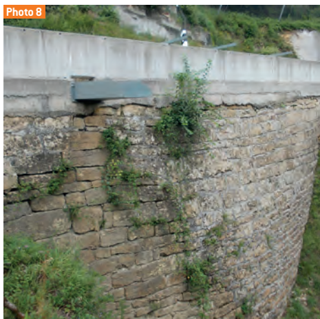
Exemples de disjointoiement ou d'altération des joints.
