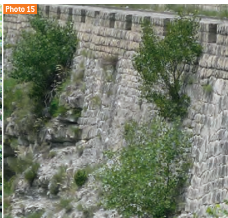
Exemples de lacunes en blocs (départ de la maçonnerie de parement) ou formation de cavité dans la maçonnerie.
